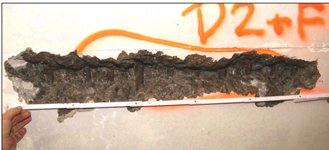
Obr. č. 11 - detailní pohled do sondy SNK2, provedené pro ověření hlavní tahové výztuže ve spodním líci NK, pravé části
