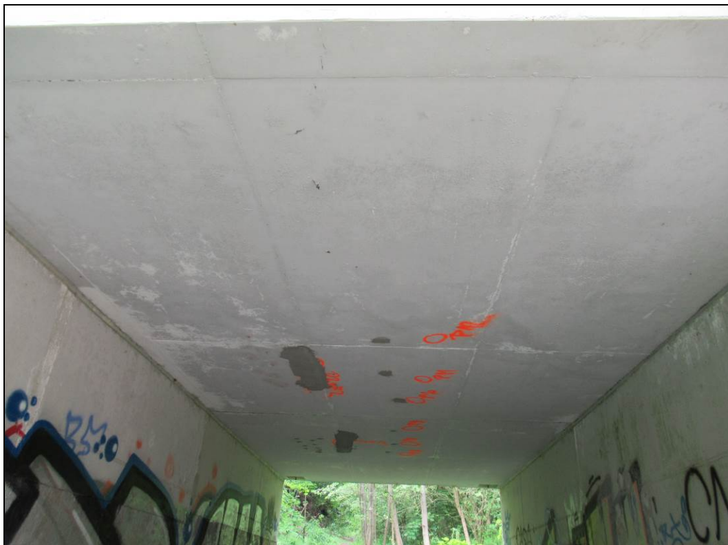
Obr. č. 9 - pohled na nosnou konstrukci, odtrhové zkoušky P7 - P9 byly provedeny na spodním líci NK levé části, P10 - P12 pak na pravé části NK. Sondy pro ověření výztuže SNK1 a SNK2 jsou patrné vlevo od odtrhových zkoušek.
