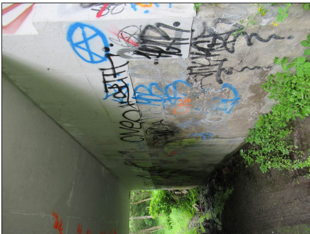
Obr. č. 8 - pohled na opěru Adamov, odtrhové zkoušky P4 - P6 byly provedeny na spodní části spodní stavby
